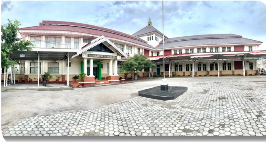
Gambar 7. Bangunan Kantor Balai POM di Palu
